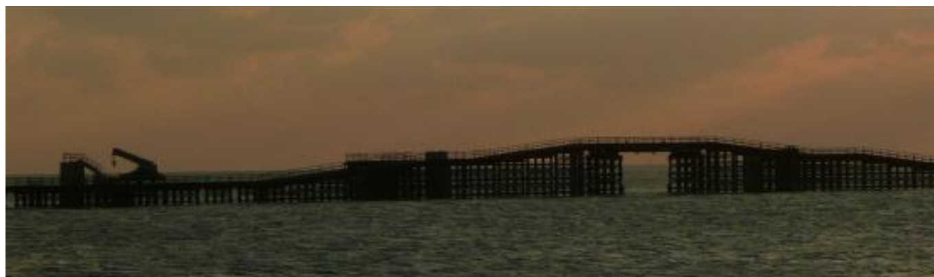
架橋工事の宮古島寄りの写真
